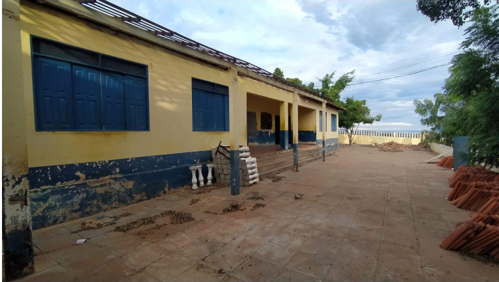
Foto 02 – Vista do Colégio de Catolés. Foto de 01/02/2021.
