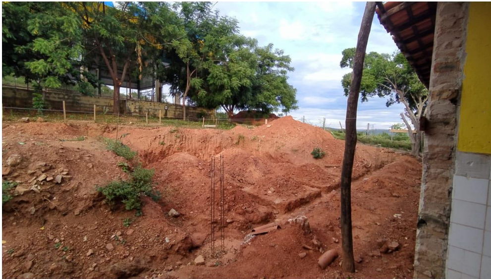
Foto 06 – Vista do Colégio de Catolés. Foto de 01/02/2021.
