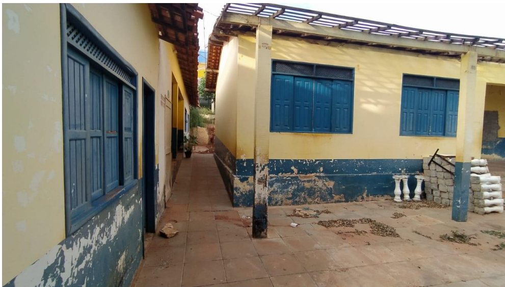
Foto 03 – Vista do Colégio de Catolés. Foto de 01/02/2021.
