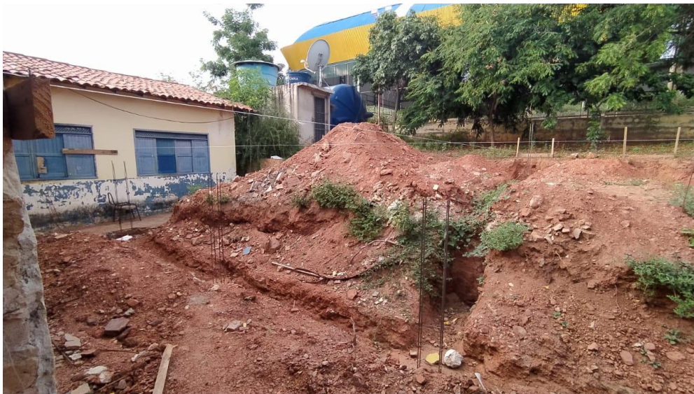
Foto 05 – Vista do Colégio de Catolés. Foto de 01/02/2021.
