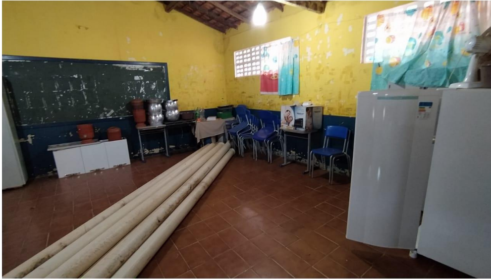
Foto 04 – Vista do Colégio de Catolés. Foto de 01/02/2021.
