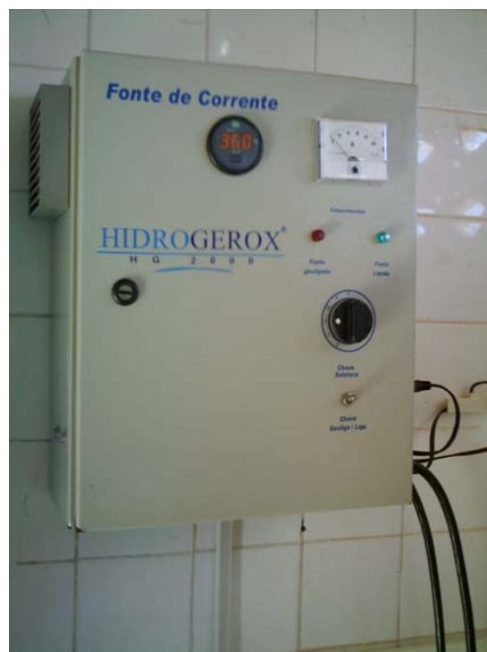
Sistema de geração e dosagem de hipoclorito de sódio
