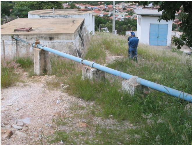
Reservatório de Contato 50 m 3
