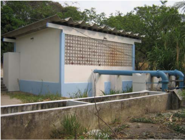
Elevatória AB – vista externa
