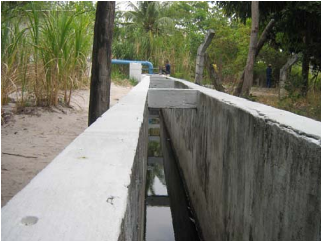
Canal de Derivação – vista interna
