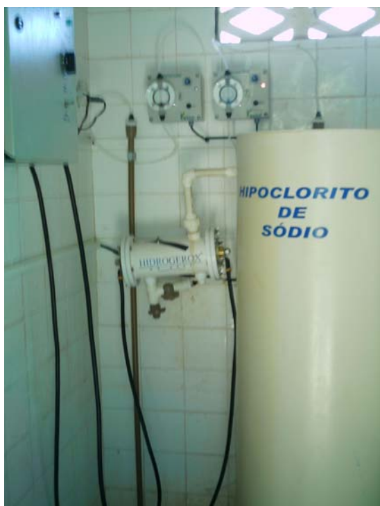
Sistema de geração e dosagem de hipoclorito de sódio
