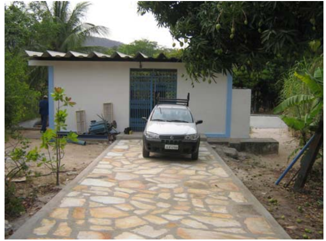
Elevatória AB – vista externa
